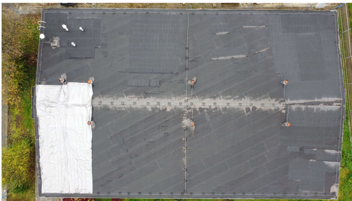
Fot.3 Dach z lotu ptaka
